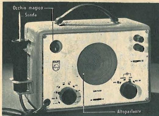
• La sonda dell'analizzatore dinamico sonoro e visivo dei guasti consente di ascoltare i vari circuiti di un ricevitore durante il funzionamento.
