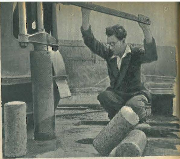
• Prelievo di campioni per studiare la struttura esatta di una strada in calcestruzzo. Questi provini vengono poi sottoposti a varie prove di resistenza.
